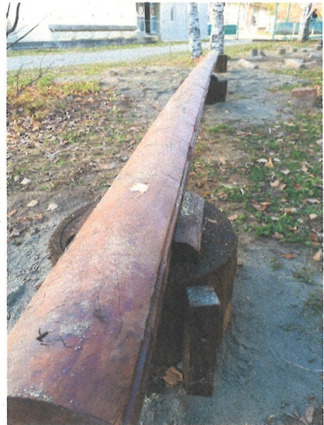
図22 完成した状況(塗装前)
