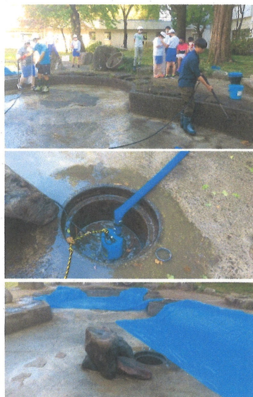
図11 池の高圧洗浄作業(上)、泥水ポンプ(中)、ブルーシートによる保護(下)
