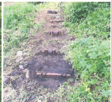
図6 設置された階段
