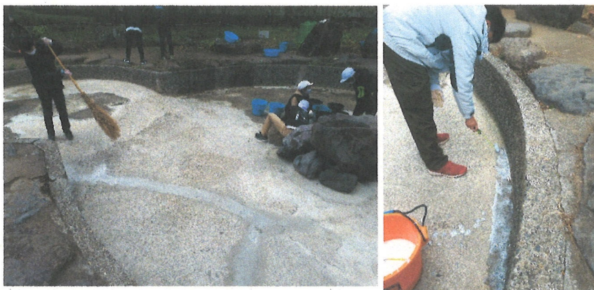
図13 池の清掃(左)、ハイフレックスの塗布(右)
