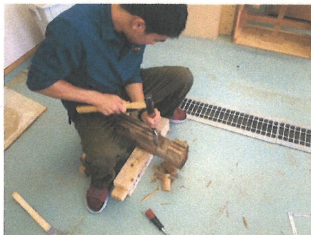
図3 階段の溝切加工の様子
