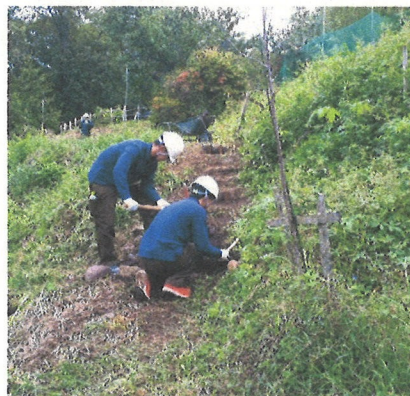
図5 階段の設置作業の様子
