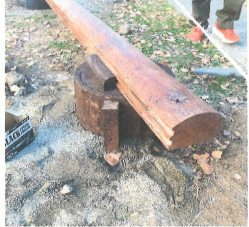
図20 台座への設置作業 (左)、台座の固定状況 (右)
