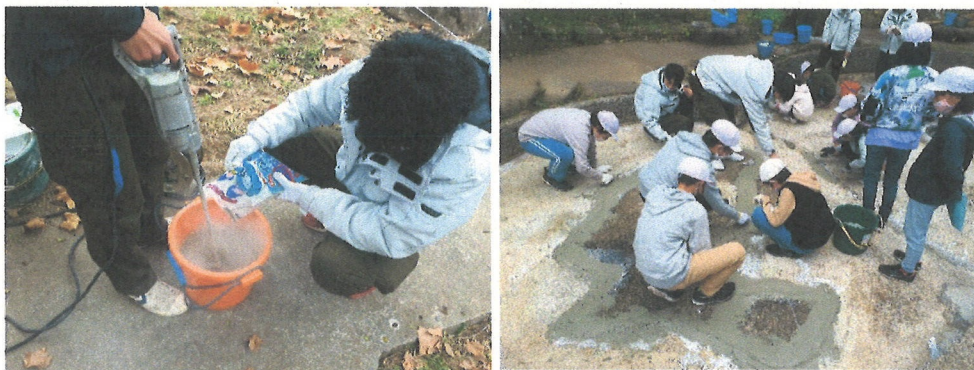
図14 セメント練り混ぜ(左)、小学生とのセメント塗り作業(右)
