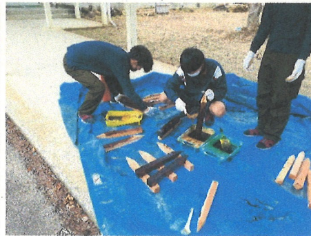
図4 防腐剤塗布の様子
