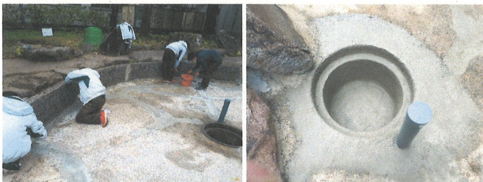
図15 午後の作業状況(左)、すべて塗り上げた釜場(右)
